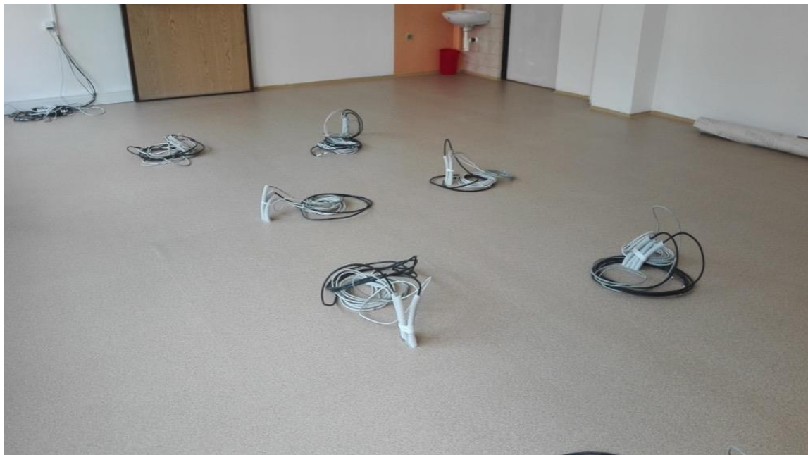
Učebna IT – připravená pro instalaci nábytku
